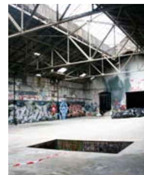
Die leerstehende Naxoshalle war für Sprayer ein Ort für künstlerische Experimente und wird derzeit abgerissen. Ein neues Wohnquartier wird entstehen.
