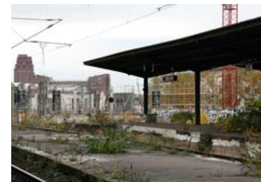
Blick vom sanierungsbedürftigen Ostbahnhof auf die Baustelle der Großmarkthalle, wo die Europäische Zentralbank 2014 einziehen wird. Fotos: hmf, K. Weber
