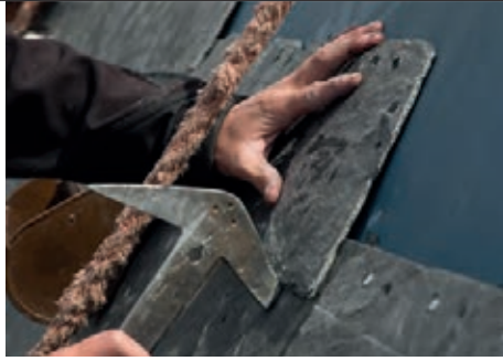
Die Dächer werden mit Schiefer gedeckt
