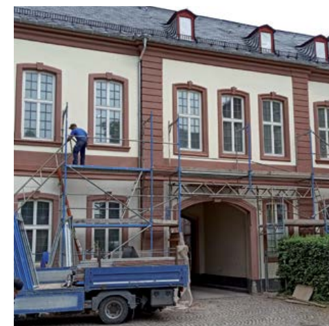
Gerüstbau am Ostflügel des Bolongaropalastes
