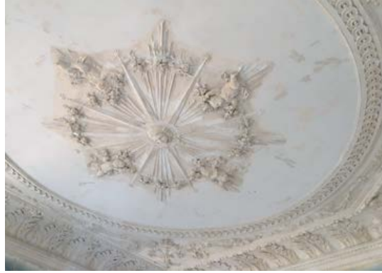
Um die Räume in ihren ursprünglichen Zustand zurück zu versetzen, wird der Stuck freigelegt.
