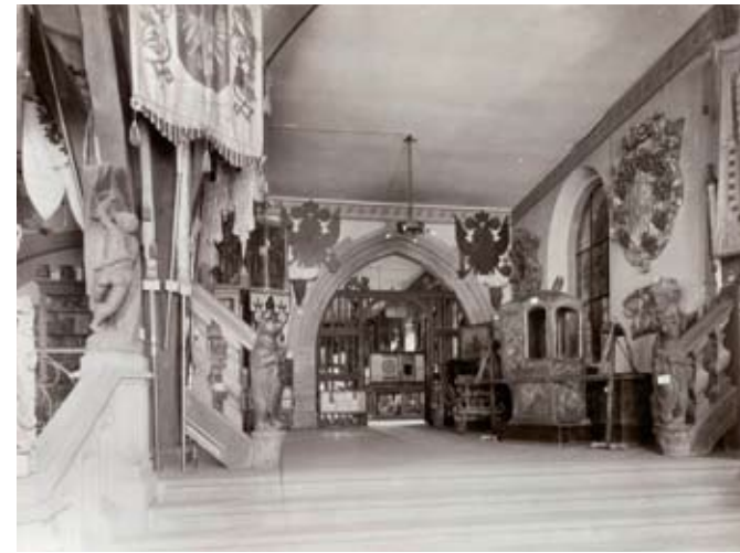
Die Erdgeschosshalle in Otto Cornills Anordnung von 1893; 1906; Fotografie von F. Lauffer (hmf Ph 10061)
