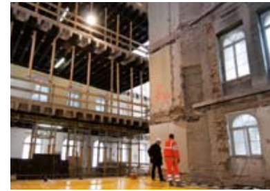
Blick in den Bernusbau, März 2010
