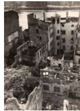
Staufertbau und Burnitzbau nach der Bombardierung vom März 1944; anonyme Fotografie (hmf Ph 1498)
