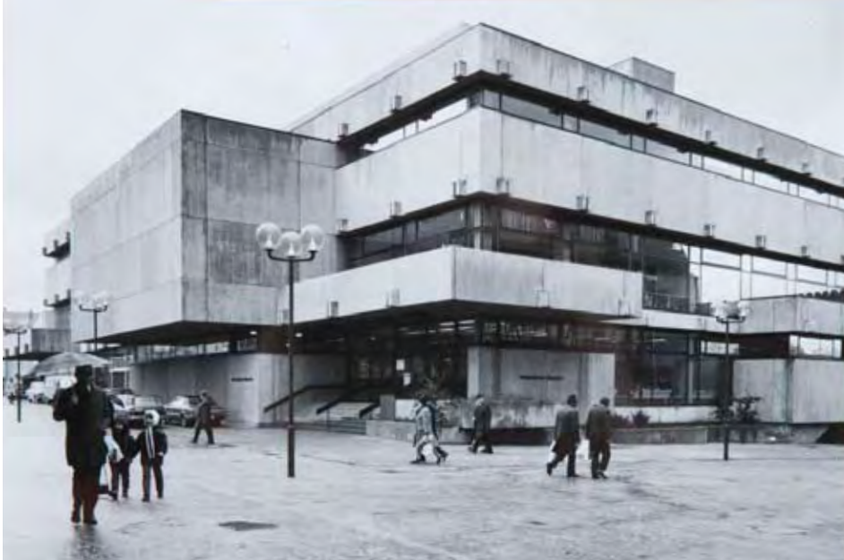
Die Betonbau des Historischen Museum von Nordwesten, nach der Eröffnung im Oktober 1972, Fotografie Fred Kochmann / historisches museum frankfurt
