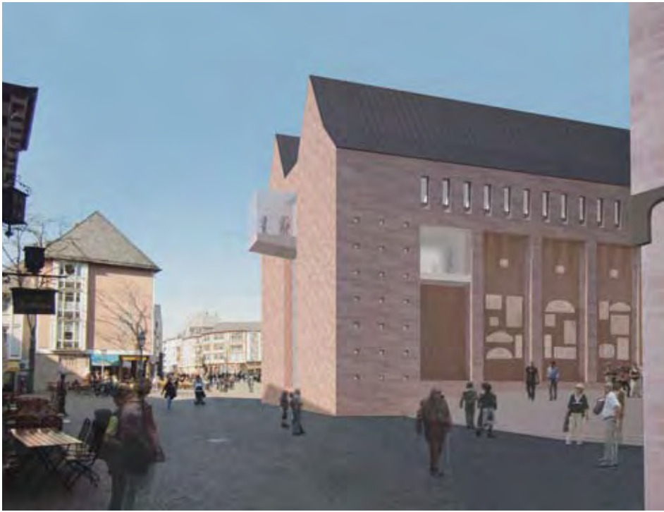
Visualisierung des Ausstellungsbaus von Südwesten, mit Blick auf die große Freitreppe; Copyright Architekten April 2011
